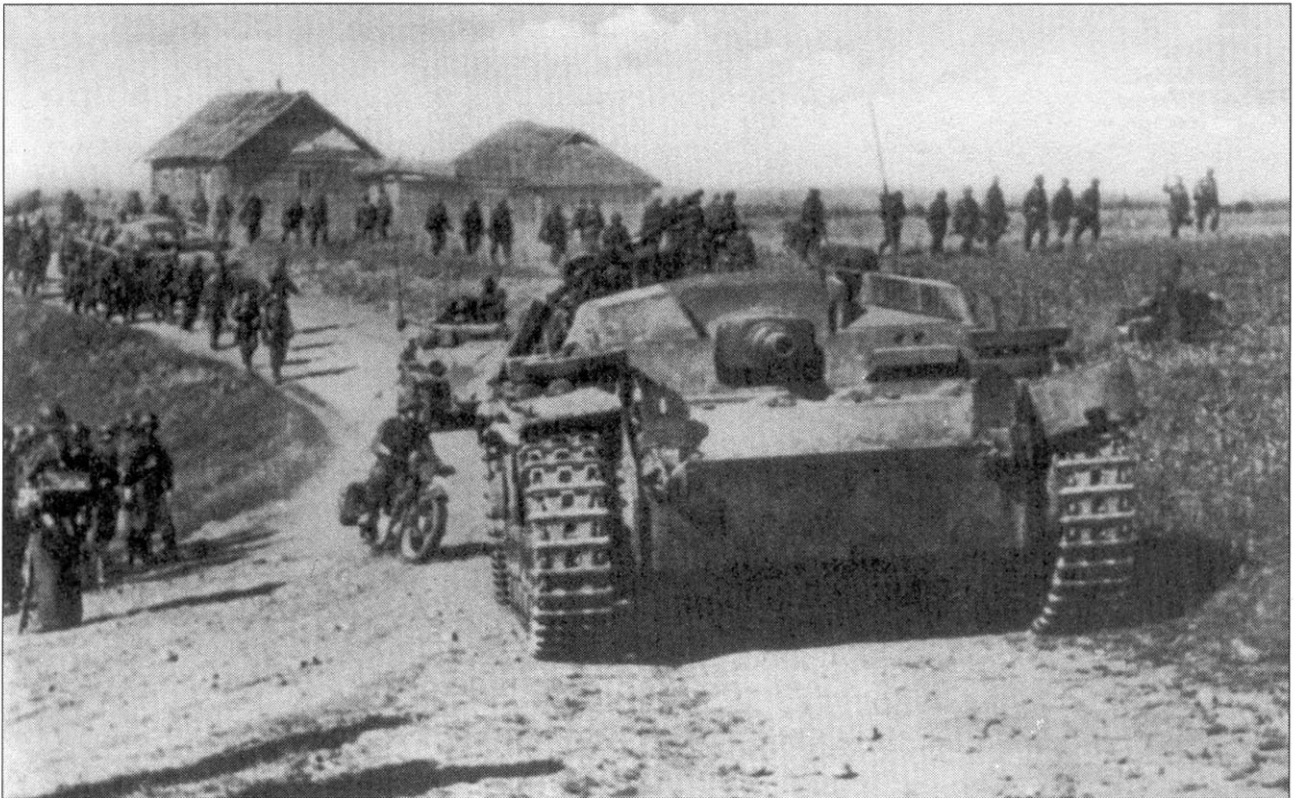
Немецкая мотопехота при поддержке Sturmgeschütz Ausf. B продвигается по украинскому селу, 1941 г. Машина сильно запылена, крылья помяты, на левом и правом крыльях видна полевая доработка - прикреплен запасной опорный каток. Над люком заряжающего установлен пулемет. Позади самоходки веден полугусеничный транспортер боеприпасов SdKfz 252. Несмотря на относительно высокий уровень моторизации вермахта, основная часть пехоты по-прежнему передвигалась дедовским способом - пешком.
