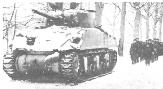
**M.4A3 E8 Sherman:** El E8 o "Easy Eight" fue la culminación de la evolución de este tipo de vehículos y llegaron a construirse cerca de 800 aparatos. El armamento principal de los modelos anteriores fue cambiado en este por un 76 mm, además de un motor con 8 cilindros en V. 3.370 modelos de la versión anterior a esta (la M.4A3) también iban equipados con estas modificaciones, pero se diferenciaban de la E8 en que la placa frontal era menos inclinada.
